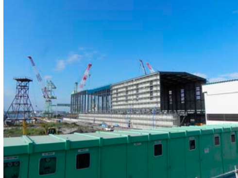
着々と復旧工事が進む大曲工場
