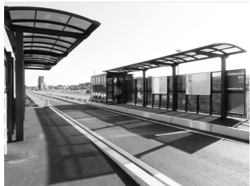
BRTで仮復旧したJR気仙沼線最知駅
