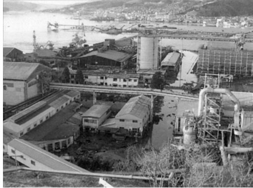
津波で水没した大船渡工場
