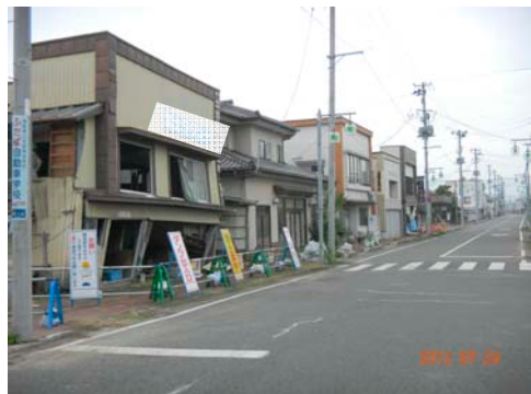
小高駅前の倒壊したままの建物
