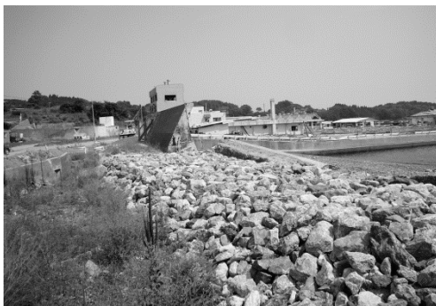
現在も破壊されたままの防潮堤
