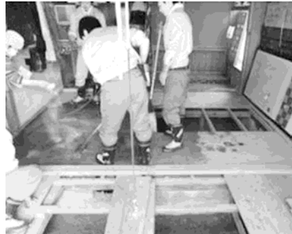
床を剥いでの泥だしと洗浄
